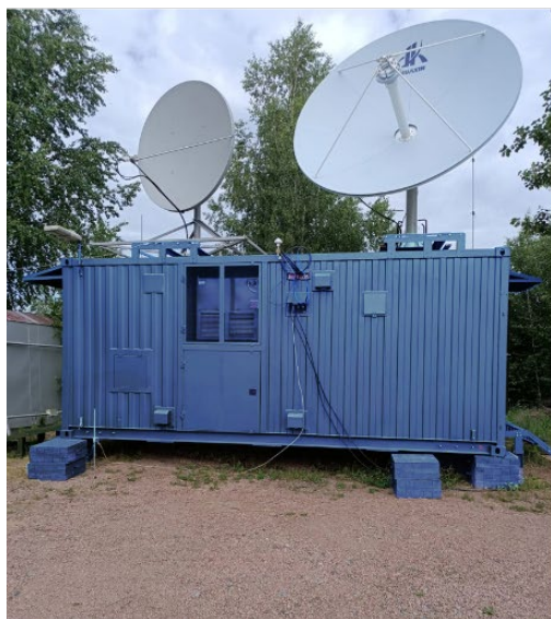
Рис. 2. Фотография и характеристики действующего макета узла связи в контейнерном исполнении
