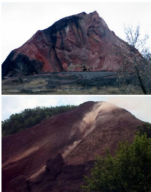
Рис. 5. Террикон шахты 41-бис и обрушение террикона шахты «Центральная» (ДНР, 2011 г.).
