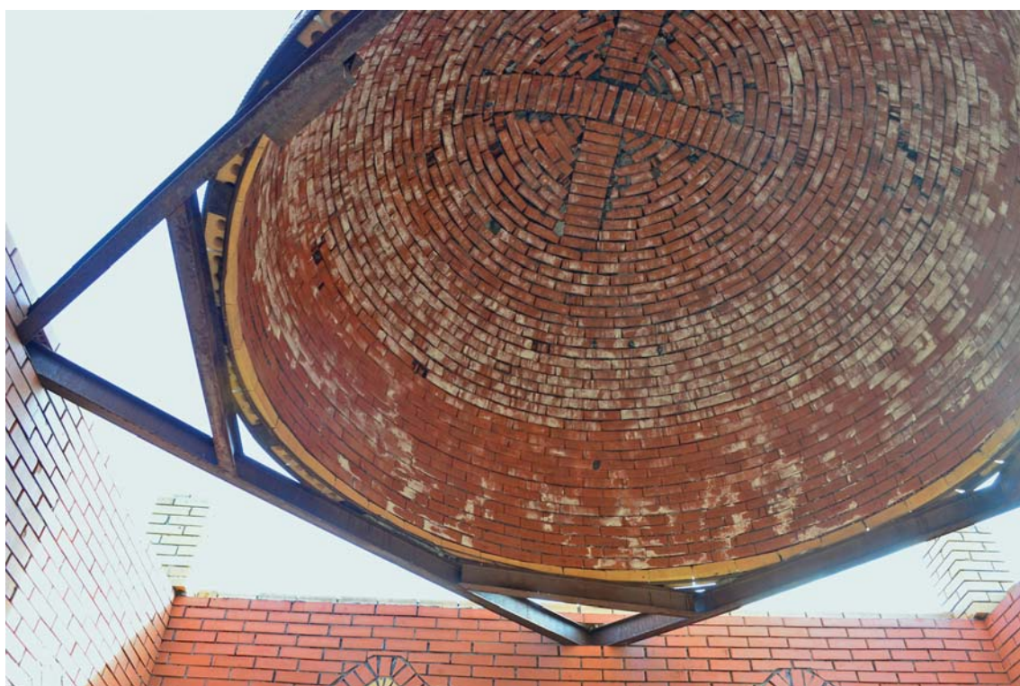
Рис. 5. Фрагмент внутреннего свода купола из кирпича, установленного на металлической конструкции над мазаром на кладбище Хаир-Ихсан, Омский р-н Омской обл. Фото Ш.К. Ахметовой, 2020 г.
